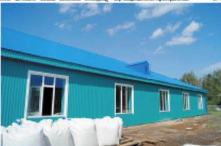
Здание нового рыбоконсервного цеха готово, осталось провести окончательную отделку фасада здания.
